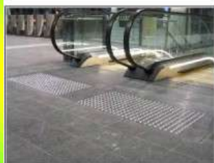
Sobre Piso Cerâmico
