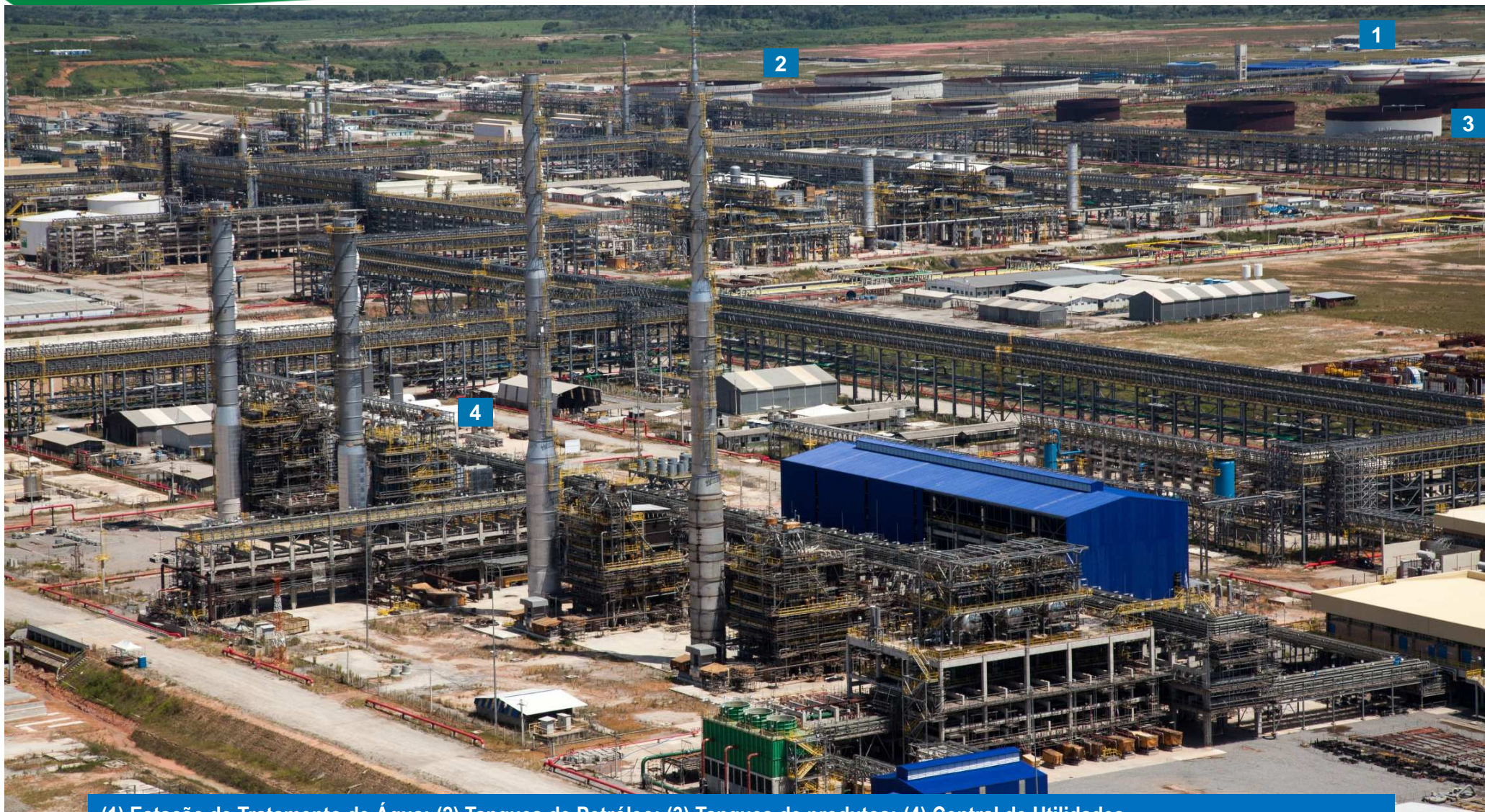
(1) Estação de Tratamento de Água; (2) Tanques de Petróleo; (3) Tanques de produtos; (4) Central de Utilidades.
