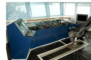
Console de Passadiço
