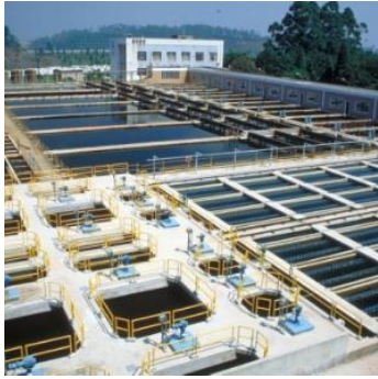
Descontaminação de água/ar
