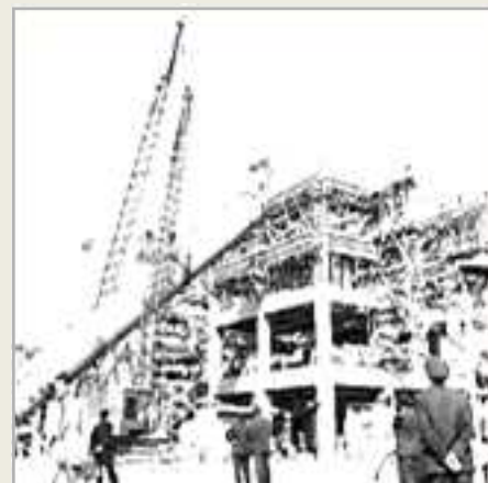
Construção da Refinaria de Cubatão (1952)
