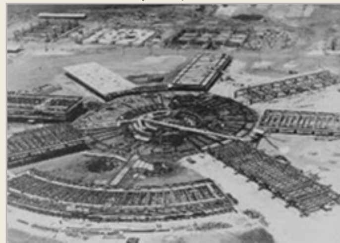
Construção do Centro de P&D (1971)
