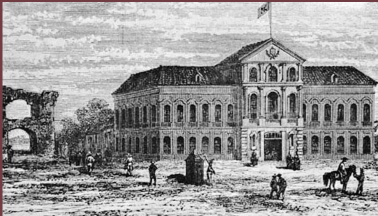
Palácio do Grão-Pará. [18—]. Domínio Público.
