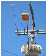
Iluminação Original (Vapor de Sódio)
