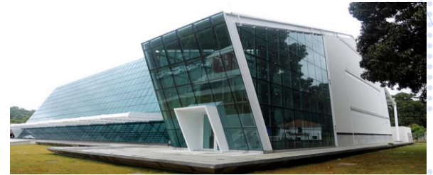
Centro de Operações Espaciais do SGDC no Rio de Janeiro/RJ
