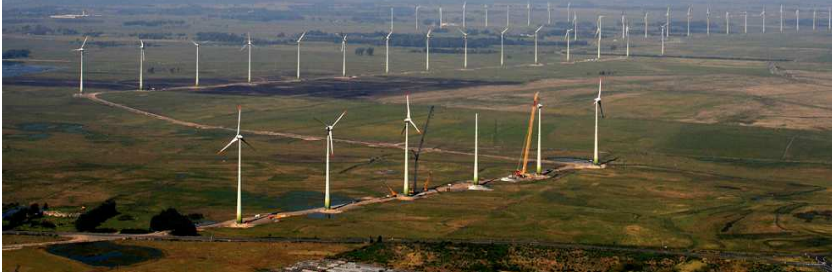
Parque Eólico de Sangradouro – RS
