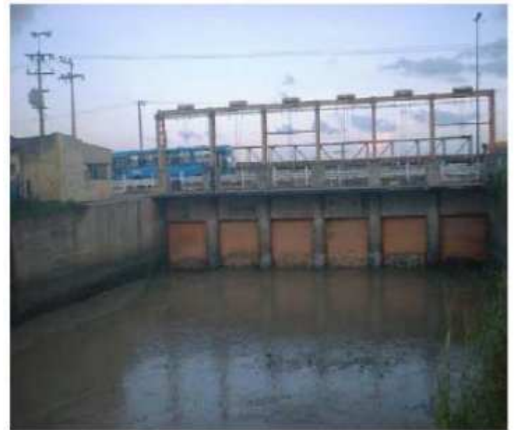
Vista frontal do vertedouro e comportas da Barragem do Bacanga
