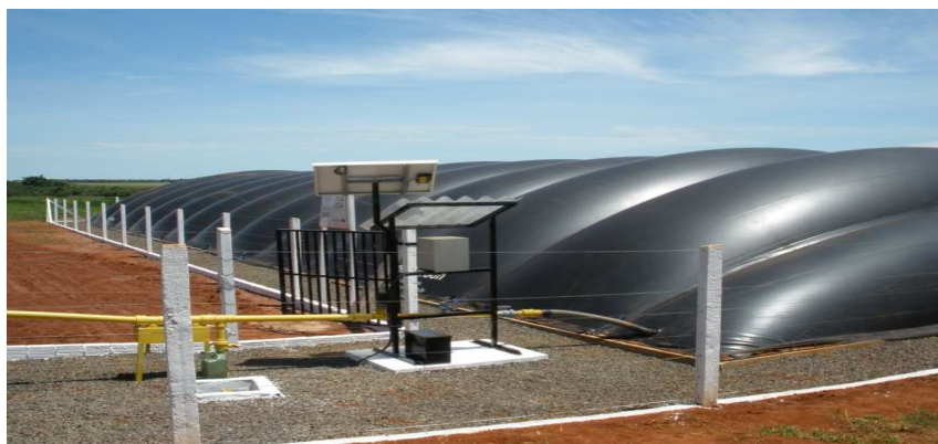
Embrapa Pantanal – sistema de produção de biogás e biofertilizantes por biodigestão da suinocultura
