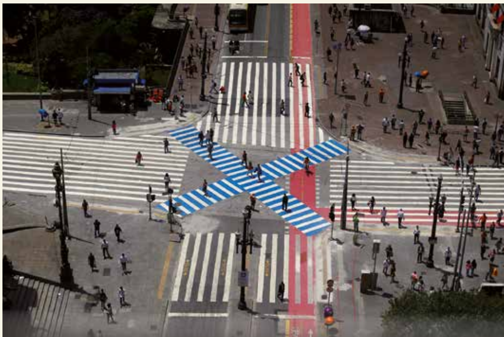
Figura 30. Priorização do pedestre: cruzamento com faixa em “x” em São Paulo (SP)
