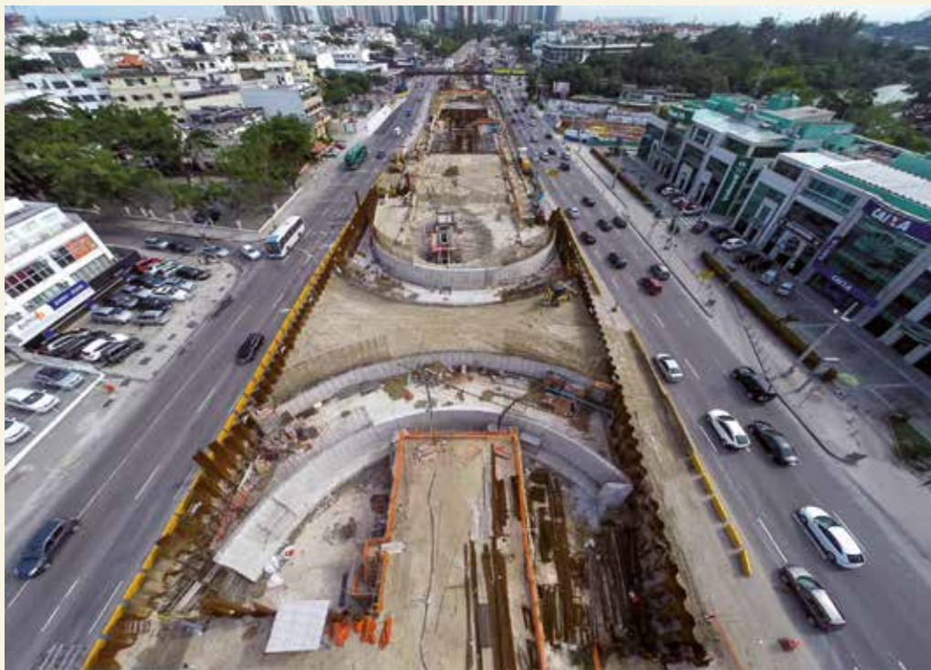
Figura 19. Obras da Linha 4 do Metrô do Rio de Janeiro (RJ)
