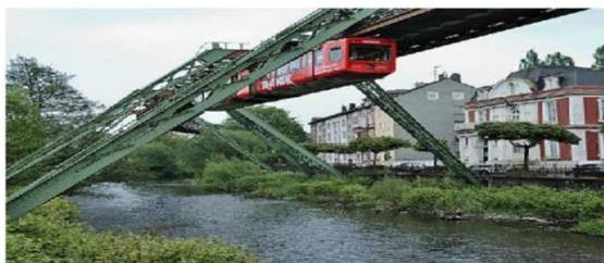
A linha ferroviária suspensa de Wuppertal, Alemanha, é uma das maravilhas da engenharia ferroviária mundial. Em funcionamento desde 1901, esta estrutura ferroviária elétrica permite o transporte de passageiros e mercadorias a um nível superior ao da rua, a uma altura que chega aos 12 metros, através de composições suspensas de um mono-caril. Desenvolve-se ao longo de treze quilómetros, na região do Ruhr-Vestfália, uma das mais industrializadas da Europa.
