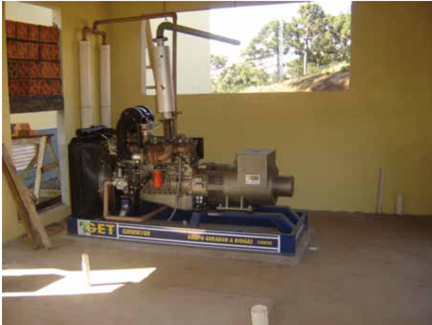
Figura 2 – Um dos geradores do sistema para produção de energia elétrica
