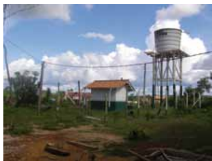
Micro-sistema de abastecimento de água
